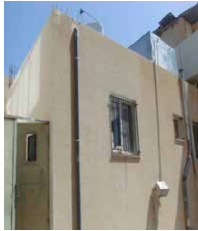
ترميم مساكن الفقراء
